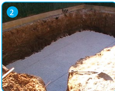
2 Preparación del terreno Ground preparing
