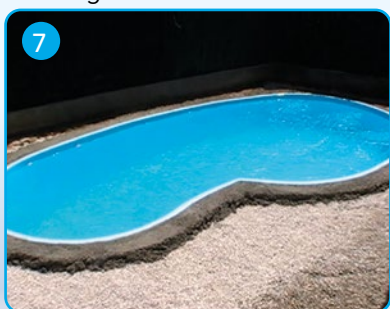
7 Asientos de brocales Coping stone placing
