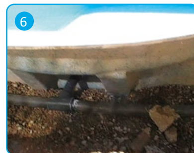
6 Conducciones periféricas Peripheral pipes
