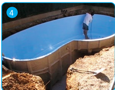
4 Puesta a nivel Levelling
